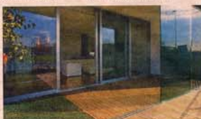
504.000 euro 120 mq al 3/4 - piano su 4 Residenze Milanofiori nord - Milano (Obr). Sere bioclimatiche con doppia vetrata per termoregolazione in estate e inverno
